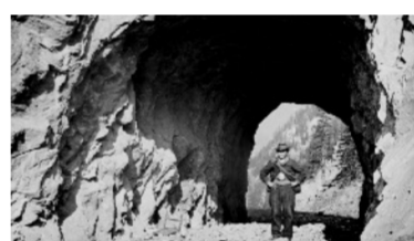
La construcziun dalla via dil Lucmagn, 1870–1877
